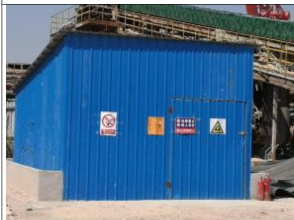
危废临时贮存所
