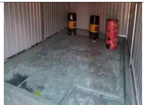
贮存所围堰及防渗
